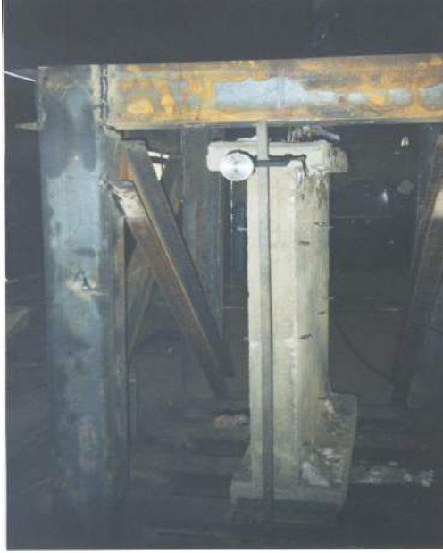
Рисунок 2.5 – Установка прогибомера при испытании однослойного фрагмента
