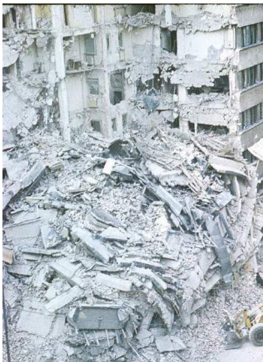
Рисунок В.1 – Разрушение многоэтажного жилого дома с несущими стенами из кирпичной кладки в результате Румынского землетрясения 1977 года
