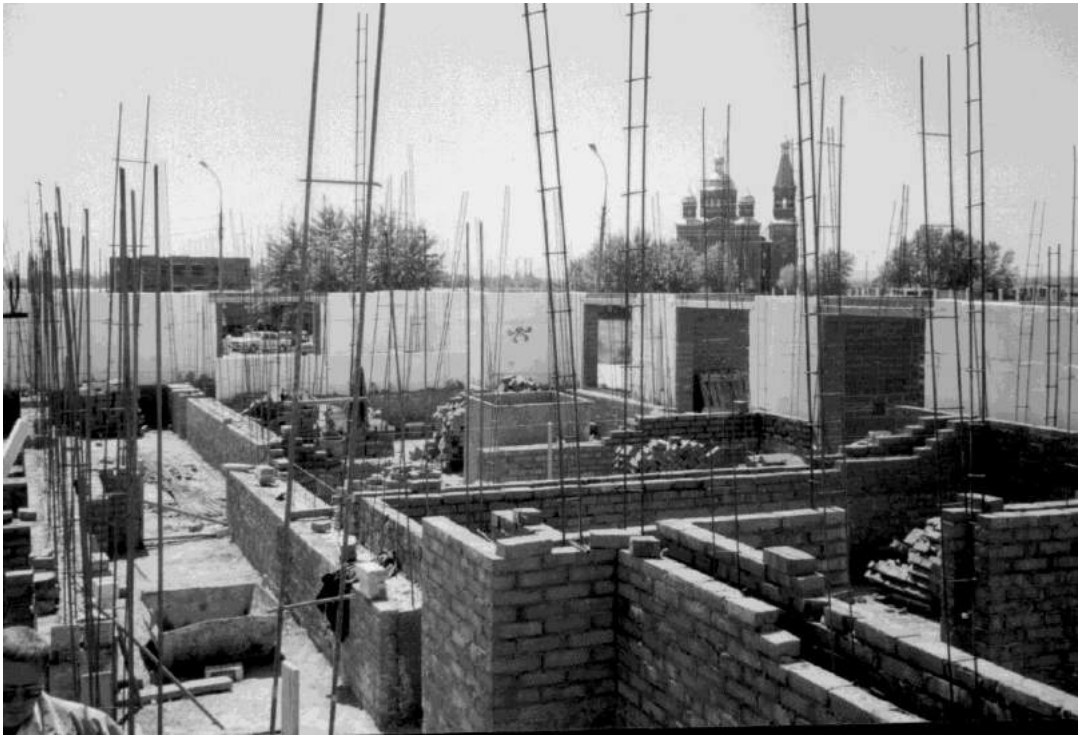
Рисунок 1.8 – Возведение 9-14-этажного дома в г. Краснодаре
