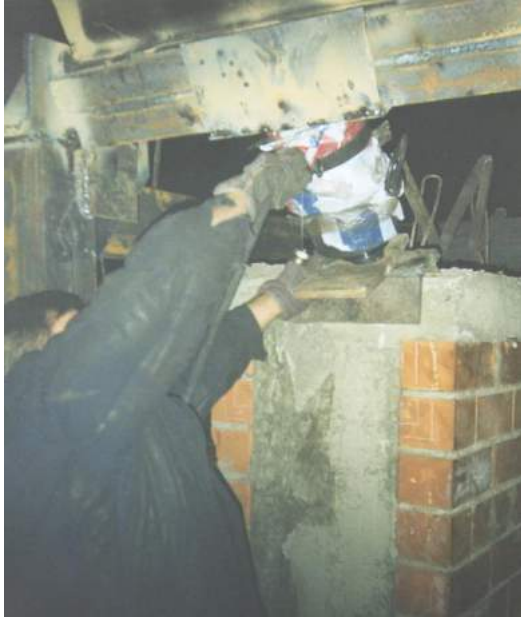
Рисунок 2.1 – Установка домкрата в рабочее положение
