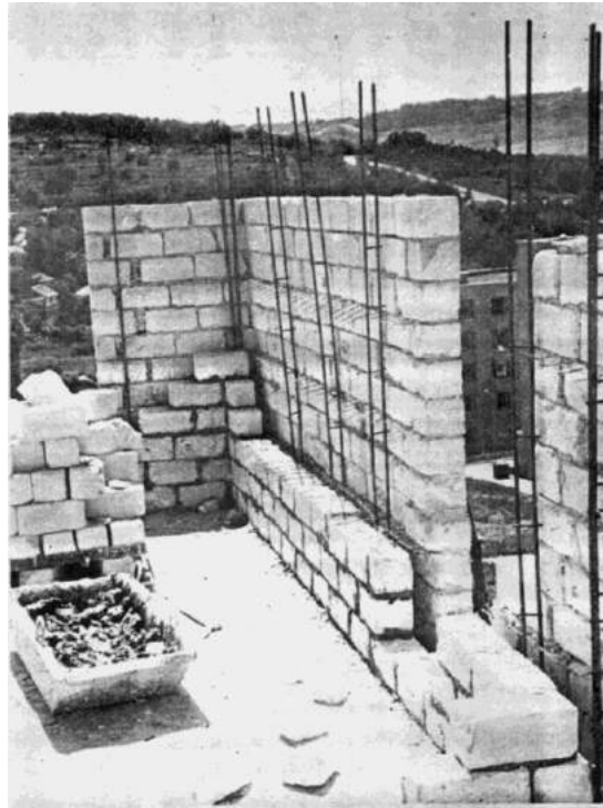
Рисунок 1.5 – Фрагмент трехслойной стены высотного дома в г. Кишиневе
