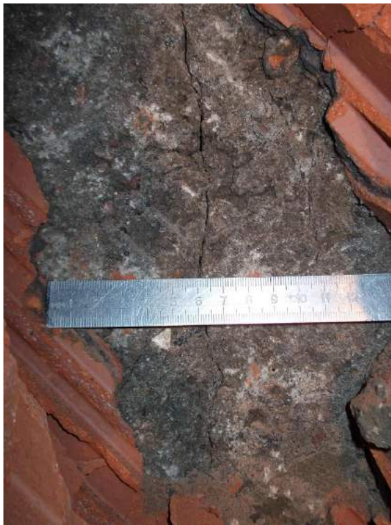
Рисунок 2.36 – Диагональная трещина внутреннего железобетонного слоя
