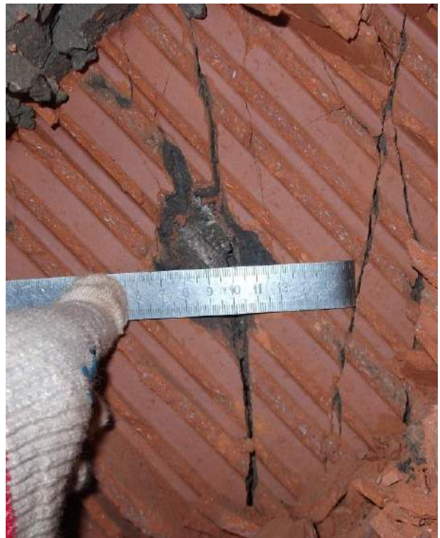
Рисунок 2.36 – Диагональная трещина внутреннего железобетонного слоя
