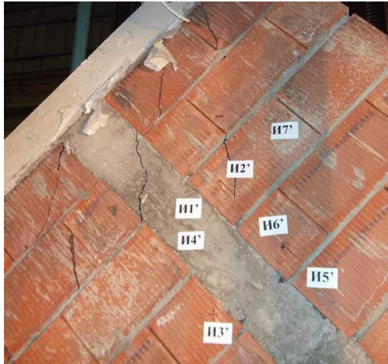
Рисунок 2.54 – Раскрытие трещин в образце ВК-2. N_p=280 кН
