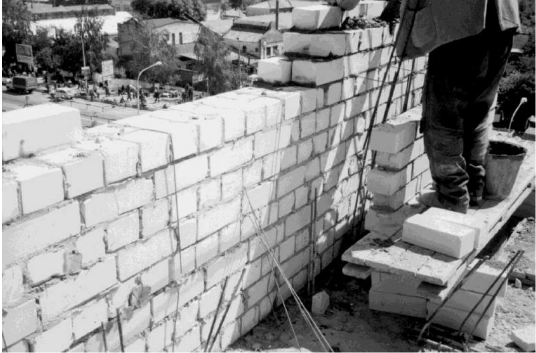
Рисунок 1.6 – Наружная стена 12-этажного жилого здания в г. Краснодаре
